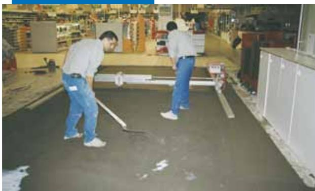
Mise en place et surfacage de la chape à la machine
